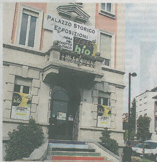
Palazzo storico delle esposizioni in via Matteotti a Mariano
